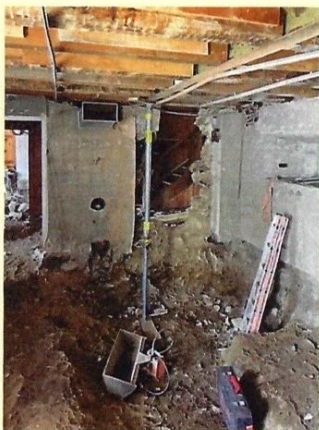
Entkernung und Tieferlegung des Bodens im Küchenbereich
