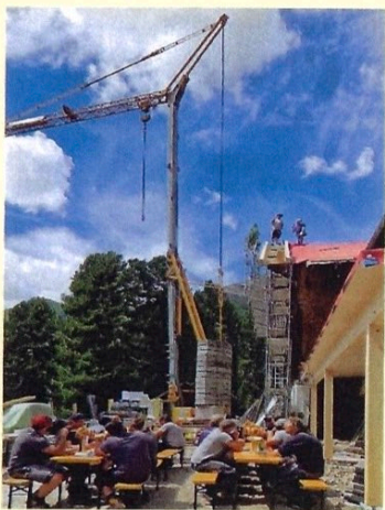
Richtfest am 26. Juli 2024 für den Anbau
