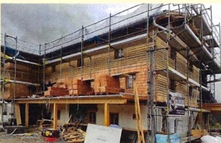
Neuverschindelung der Südseite des Gepatschhauses
